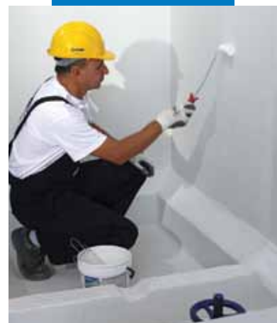
Nánášení Mapecoatu DW 25 válečkem
