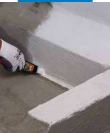
Nanášení Triblocku P ve styku podlahy a přilehlé svislé stěny
