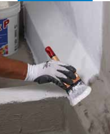
Nanášení Triblocku P štětcem na vlhký podklad
