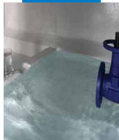
Plnění nádrže po úplném vytvrzení Mapecoatu DW 25
